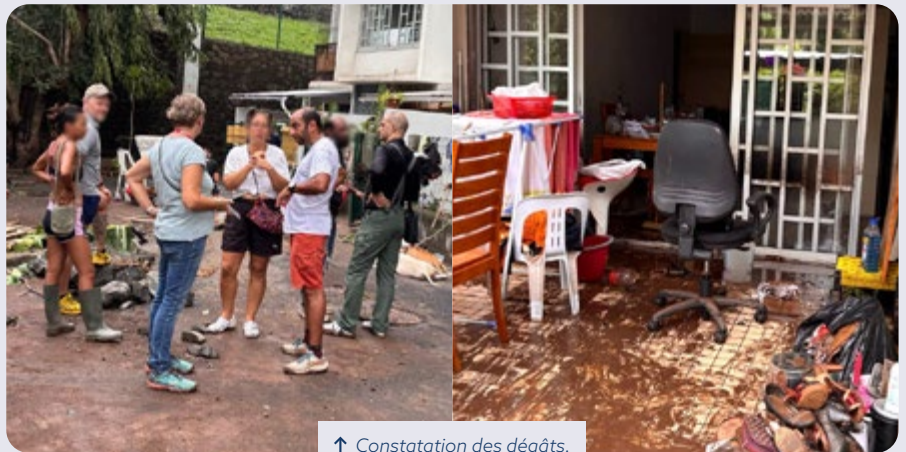
↑ Constatation des dégâts.
